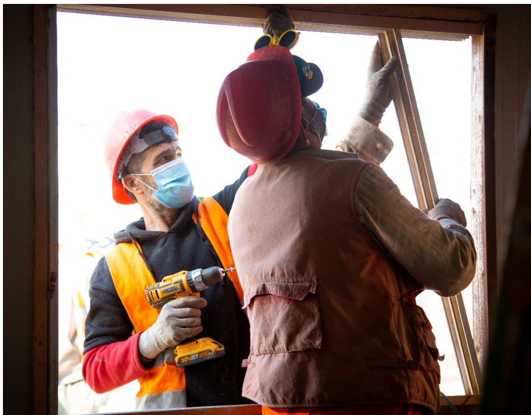
Voluntarios basados en incentivos instalando una ventana como parte de las reparaciones del NRC de casas rodantes en el campamento de Zaatari, Jordania. Foto: Tina Abu Hanna/NRC
